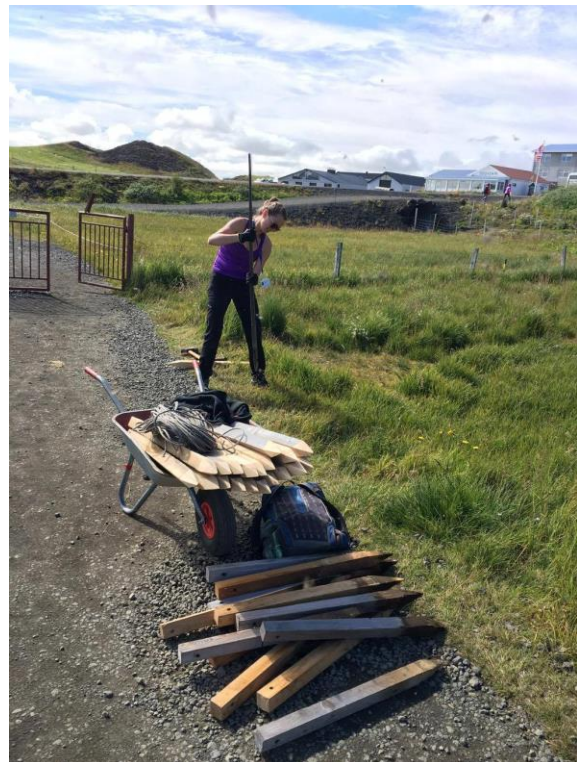
Unnið við endurnýjun kaðlagirðingar við Skútustaðagíga
